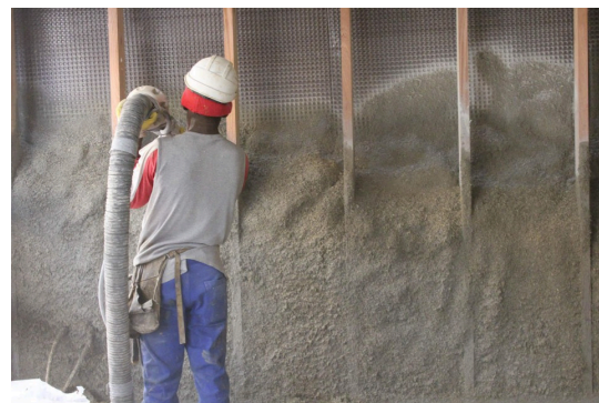
Structure ossature bois et béton de chanvre
