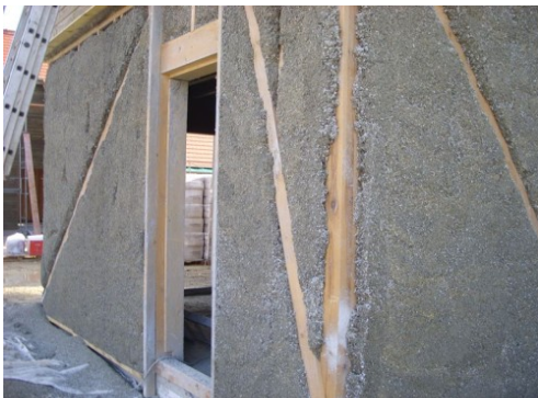
Structure ossature bois et béton de chanvre
