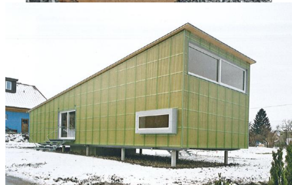
Figure 9 21 : Panneaux de paille, brique de panneaux de paille, "Maison de paille" en Suisse
