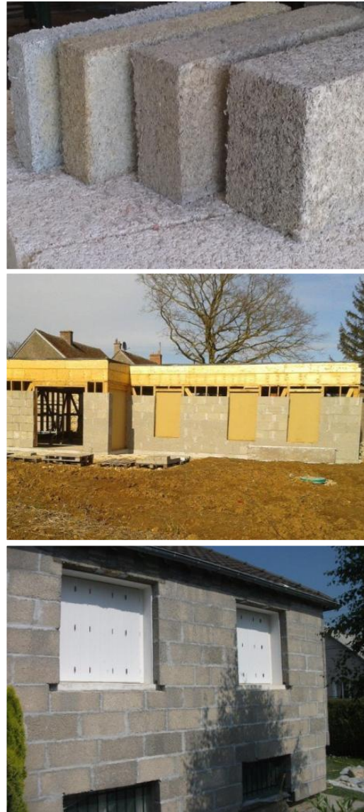
Figure 14: Paille de chanvre, différentes épaisseurs de brique, montage du mur et esthétique final
